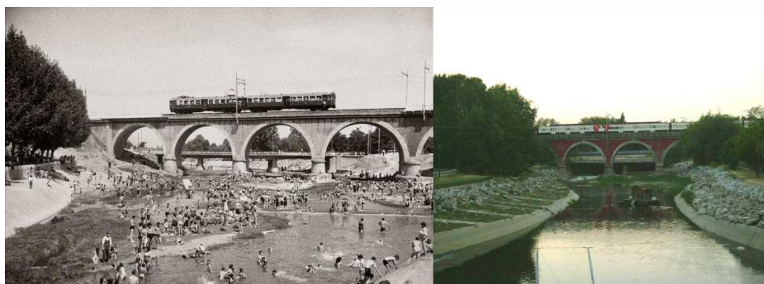
Figura 80. 1961-2012 – Vista comparativa del Manzanares delante del Puente de los Franceses.
