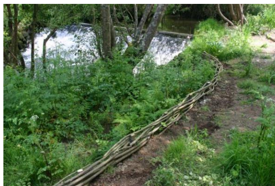
Figura 12. Rio Uíma (técnica de entrançado vivo).
