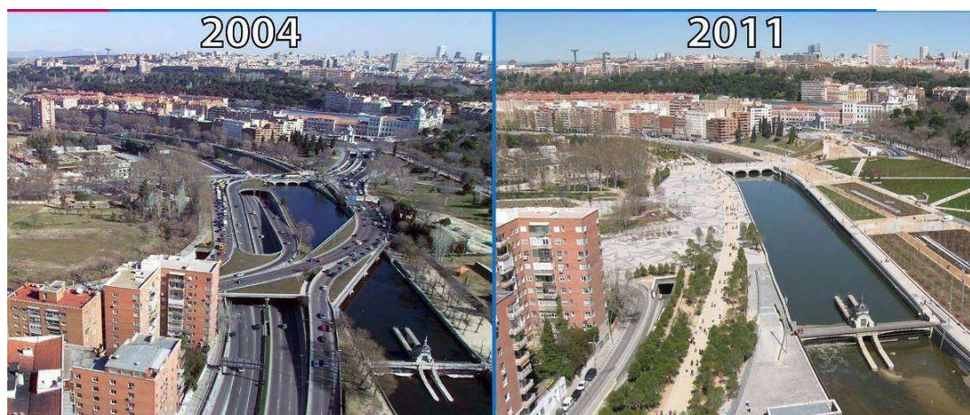
Figura 58. Antes y después del soterramiento de la M-30 en el tramo del Puente del Rey. Fuente: Ayuntamiento de Madrid
