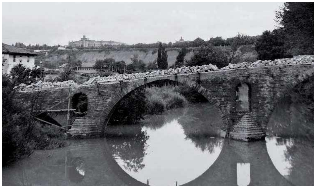
Figura 27. Reforma del puente de la Magdalena (1963)
