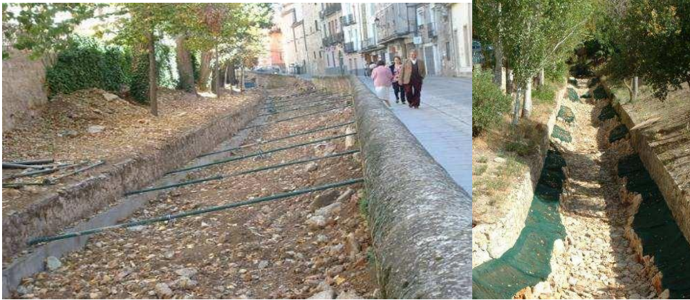
Figura 99. Trabajos en el lecho del río durante las obras de ejecución en 2005.
