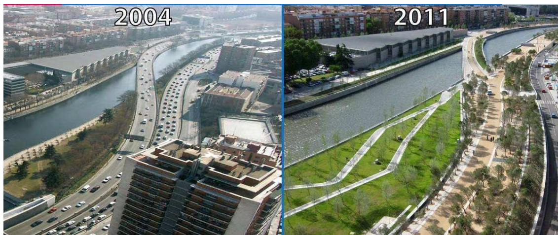
Figura 60. Antes y después del soterramiento de la M-30 en el tramo del Centro de Estudios Hidrográficos del CEDEX. Paseo de la Virgen del Puerto. Fuente: Ayuntamiento de Madrid
