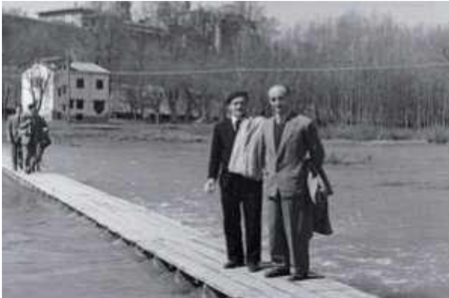
Figura 25. Las antiguas pasarelas (1951)
