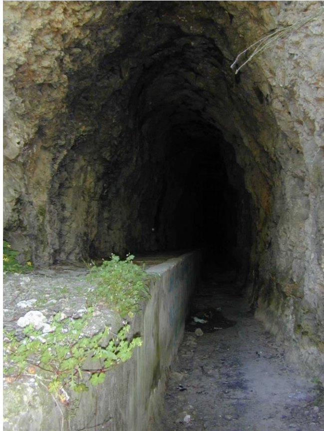
Figura 95. Salida del túnel de alivio antes de la actuación.
