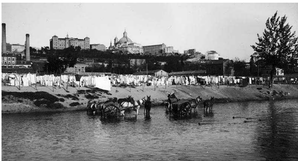
Figura 72. Extractores de arena y lavaderos en las márgenes del tramo urbano del río Manzanares. Fuente: Fototeca del Patrimonio Histórico, del Ministerio de Cultura.
