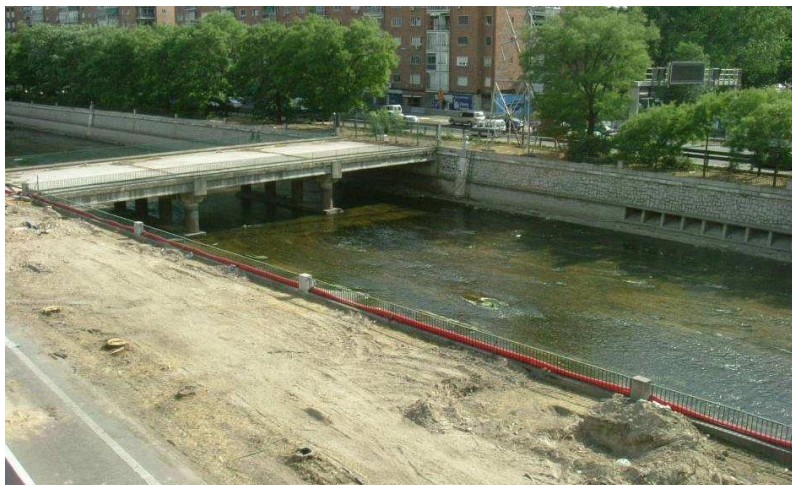
Figura 65. Obras de ejecución en la pasarela cerca del Estadio Vicente Calderón. Año 2005. Fuente: F. Magdaleno
