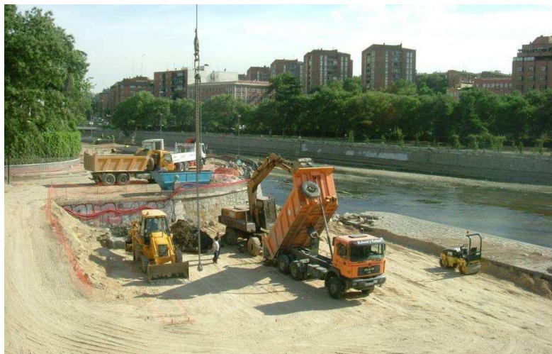
Figura 64. Obras de ejecución en los alrededores del Paseo de la Virgen del Puerto. Año 2005. Fuente: F. Magdaleno
