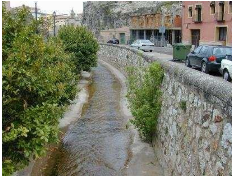
Figura 91. Aspecto del tramo urbano del río Huécar antes de la actuación. Se puede apreciar las características del encauzamiento, la falta de espacio para su dinámica, y la escasez de funciones ambientales con que contaba.
