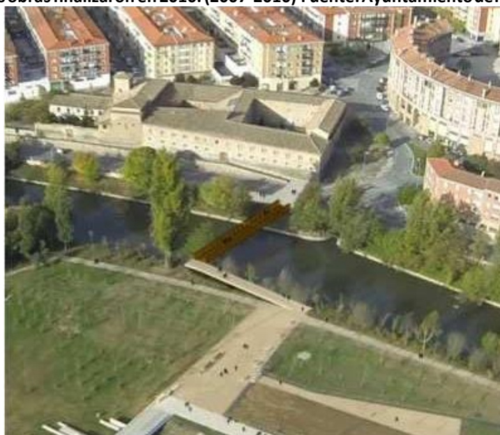
Figura 22. Pasarela peatonal entre el Parque de Aranzadi y el barrio de Rochapea. Fuente: Ayuntamiento de Pamplona.
