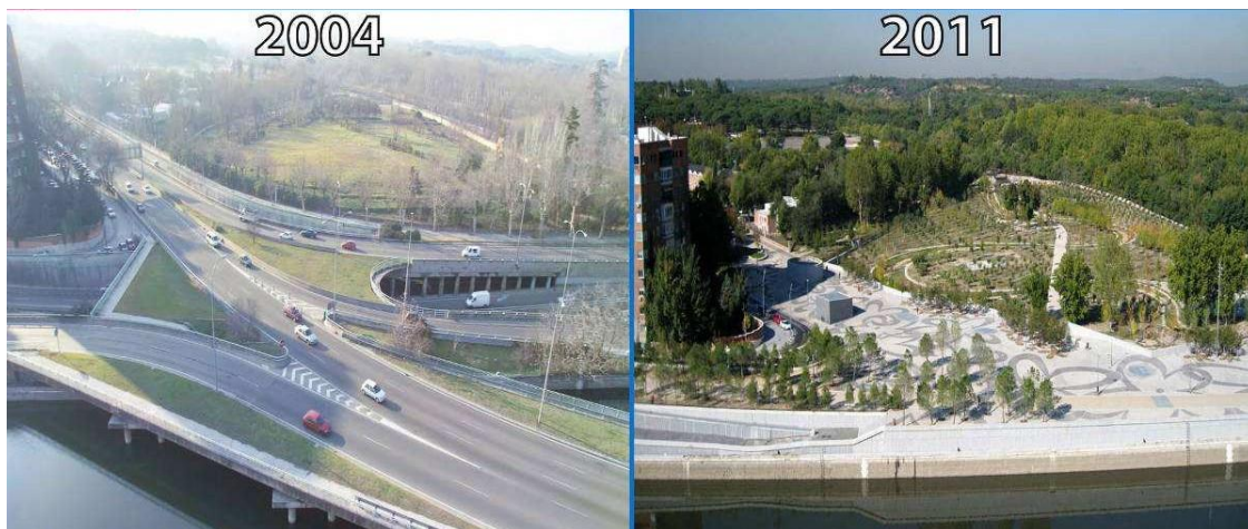
Figura 59. Antes y después del soterramiento de la M-30 en el tramo de la Huerta de la Partida. Fuente: Ayuntamiento de Madrid
