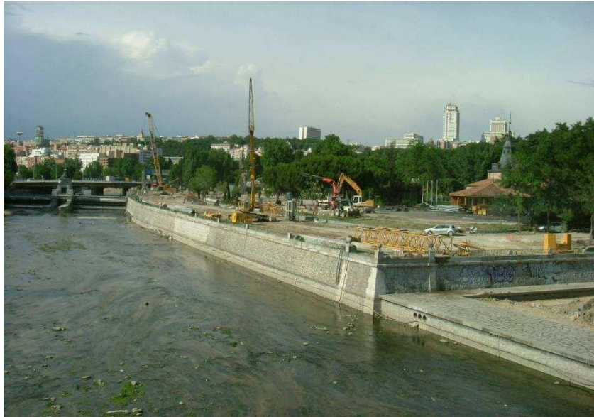
Figura 67. Obras de ejecución en la pasarela junto al Puente de Segovia. Año 2005. Fuente: F.Magdalenó
