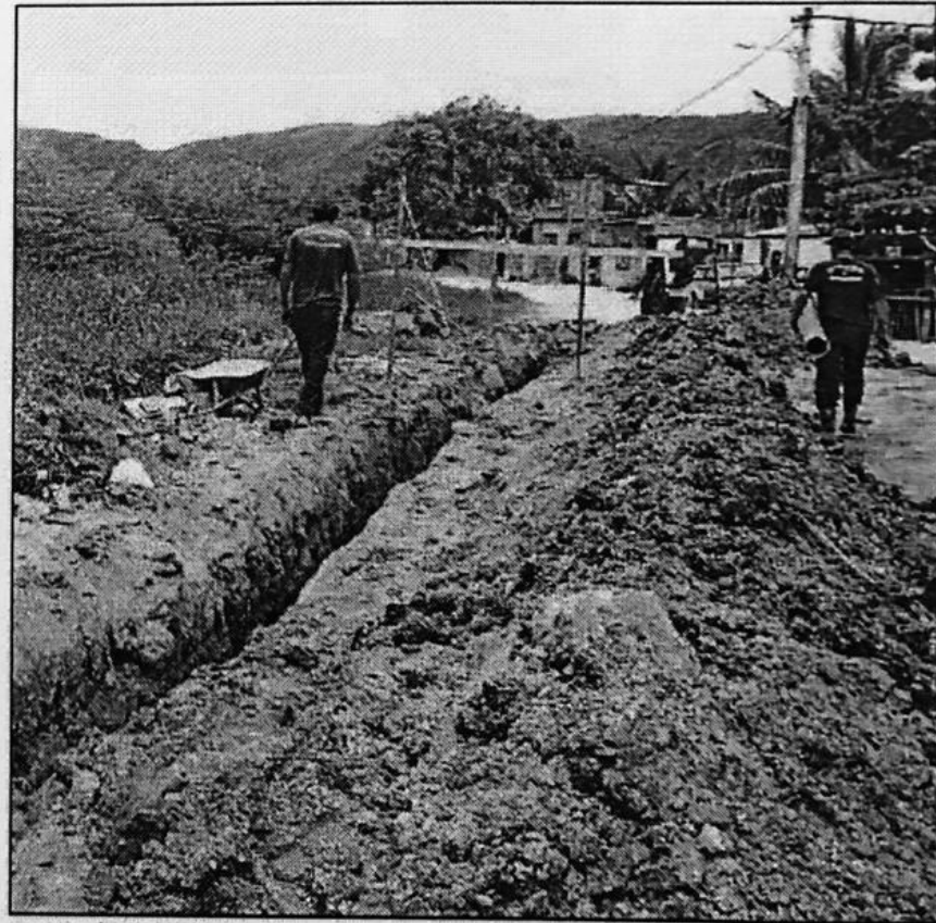
FUNCIONÁRIOS DA ÁGUAS de Niterói trabalham na conclusão da rede de esgoto na lagoa: sem despejo
