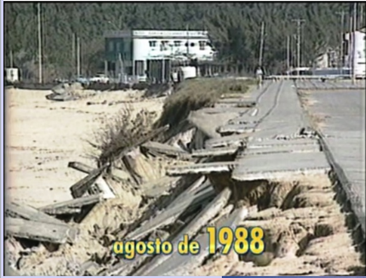
Erosão e avarias extremo oeste, 1988
