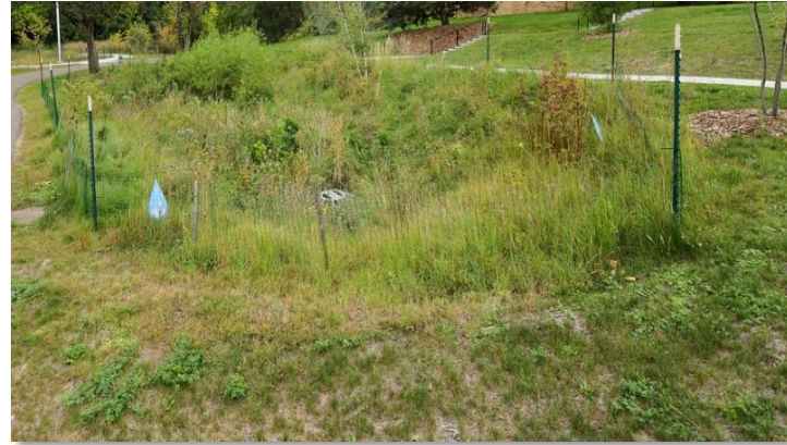
Bacia de biorretenção
