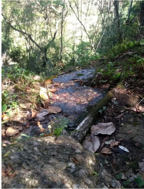
Retaludamento da calha
