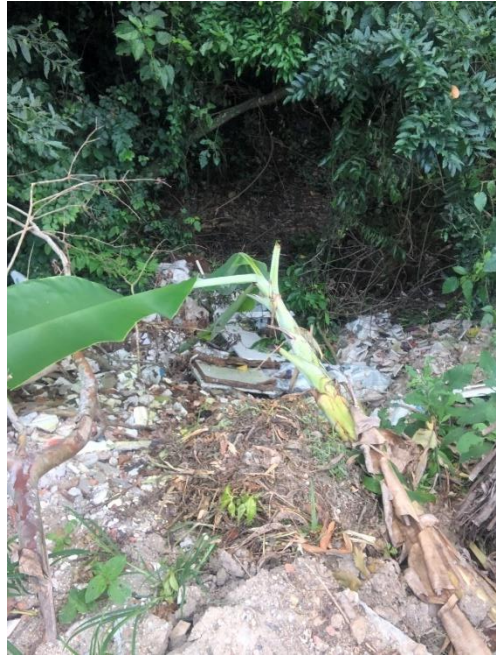
Limpeza da calha
